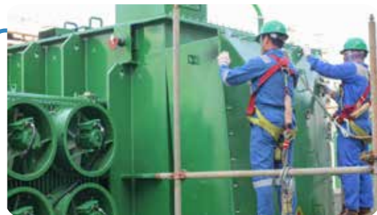
Proses Maintenance Trafo 31-PT-204 di Utilities Area II
