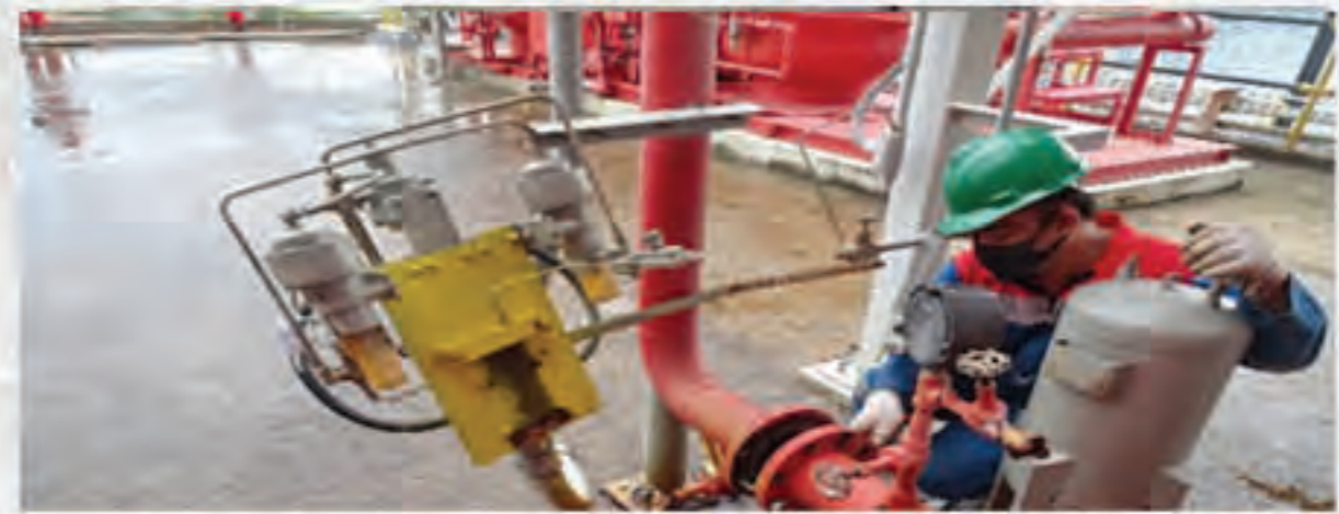
Pekerja maintenance sedang melepas blind pada fire water line menggunakan peralatan yang layak pakai.
