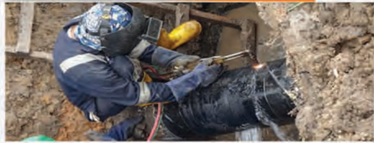
Pekerja sedang melakukan pengelasan pipa bawah tanah.
