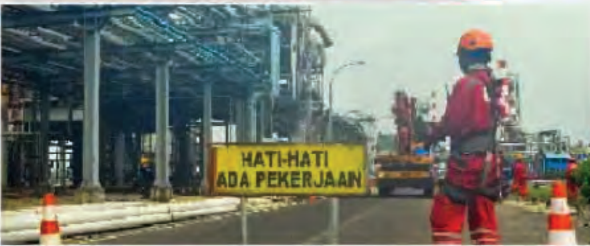
Pekerja memasang safety sign dan mengawasi kegiatan pekerjaan konstruksi.
