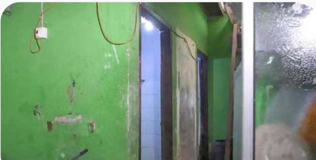
Toilet sebelum renovasi Toilet before renovation
