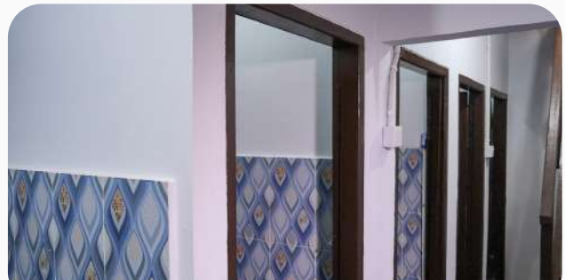
Toilet setelah renovasi Toilet after renovation
