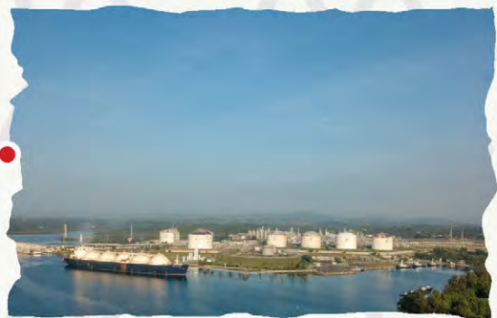
Aerial Kilang Badak LNG 2020
