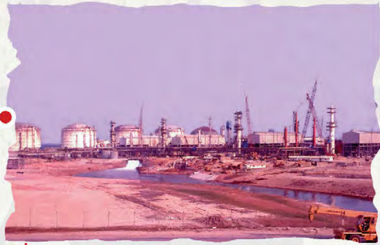
Konstruksi Train C & D tahun 1981
