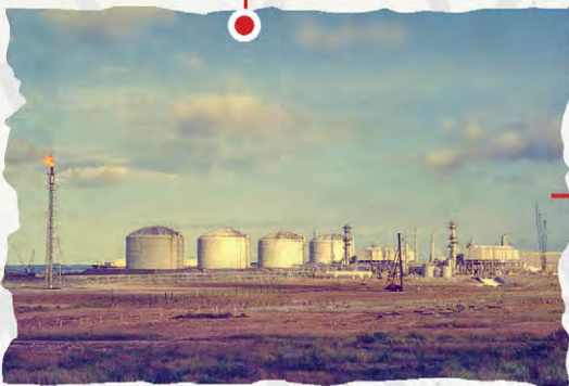
Konstruksi Train A, B, & C tahun 1983
