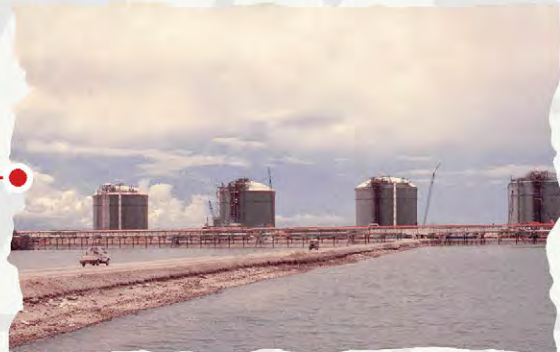
Konstruksi Tangki LNG tahun 1988
