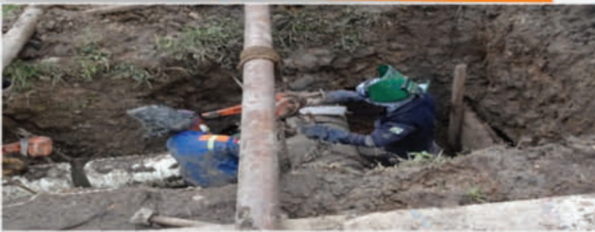
Pekerja sedang melakukan pekerjaan perbaikan pipa di bawah tanah.
