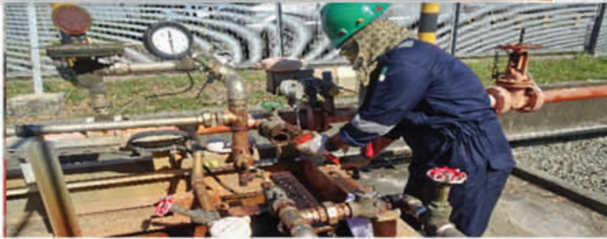
Pekerja maintenance sedang melepas turbin foam pump menggunakan peralatan yang sesuai.
