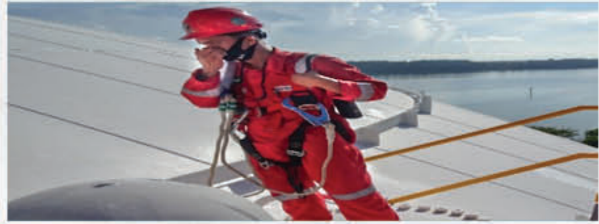
Pekerja fire & safety sedang melakukan pergantian nitrogen fix dry chemical di LNG Tank dengan dilengkapi full body harness.
